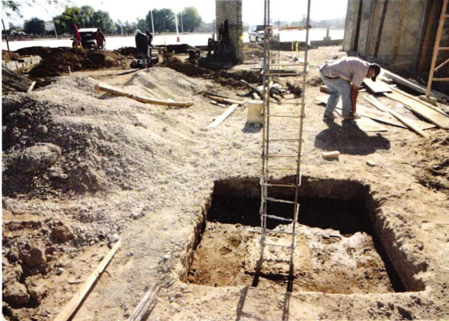
EXCAVACION, ARMADO, COLADO DE ZAPATAS
