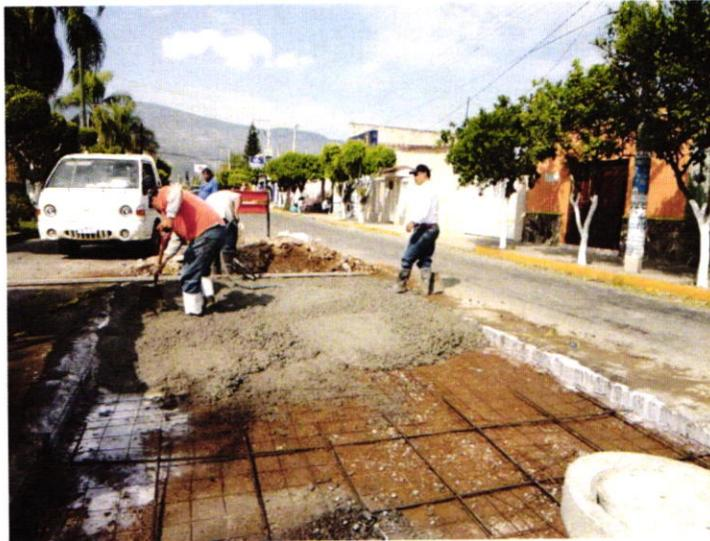
TENDIDO DE MALLA ELECTROSOLDADA, COLADO DE CONCRETO HIDRAULICO EN
