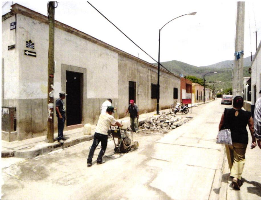
CORTE DE CONCRETO DAÑADO, COLOCACION DE MAYA ELECTROSOLDADA Y COLADO DE CONCRETO HIDRAULICO.
